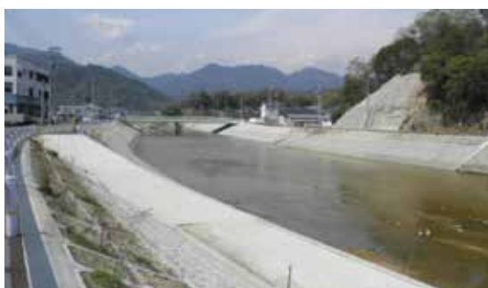
河川改修(河道拡幅)
